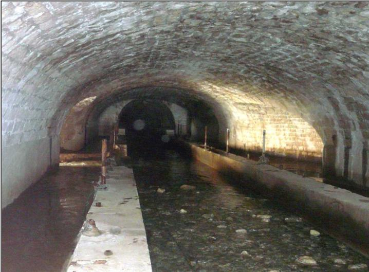
En haut : l'émissaire 1 avec des voûtes maçonnées en bel appareillage et un débit très faible des écoulements.
