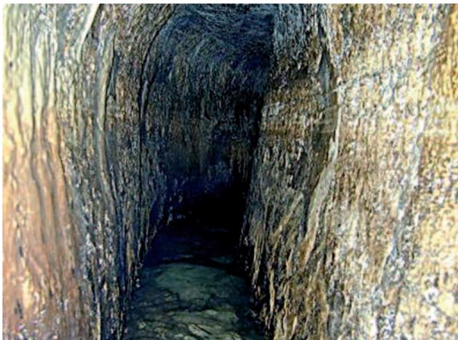
Figure 2. Le tunnel est taillé à la pointerolle et la massette, il a 1,5 m de haut pour 0,6 de large. Les coulées de calcite, visible, ont permis sa datation. Correspond-t-il à l'élargissement d'un conduit plus étroit ?
