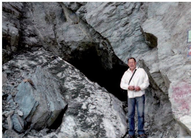
Figure 12. L'entrée du tunnel coté italien. Il a été creusé à la faveur d'une fracture facilitant le travail de la roche.
