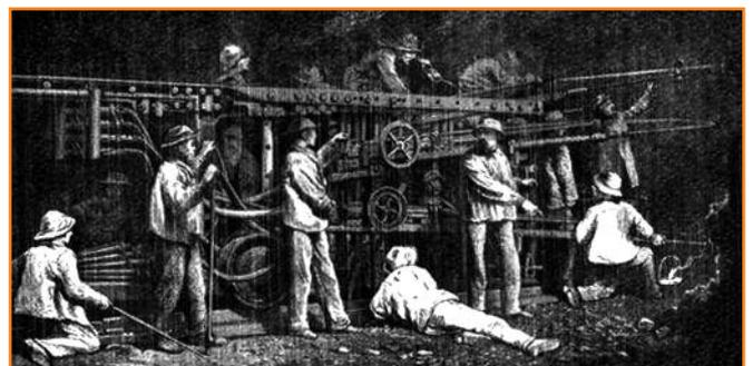
Figure 16. Perforatrice utilisée au tunnel de Fréjus (d'après Wymper en 1873).
