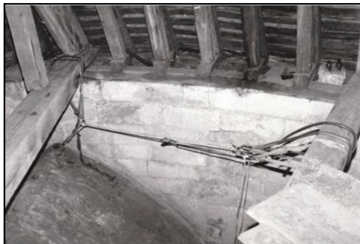
Nos amarrages aux poutres de la charpente, pour arriver à la verticale des trous.
