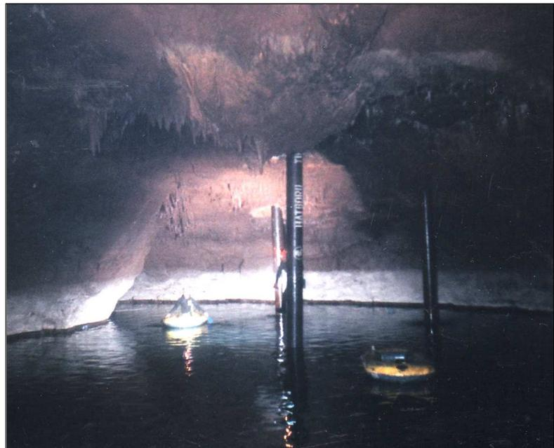
Aujourd'hui, les forages ont remplacé les puits ! Ici, un forage implanté par l'auteur au Liban, en 1998-99, pour capter l'eau d'une rivière souterraine à 465 m de profondeur.
