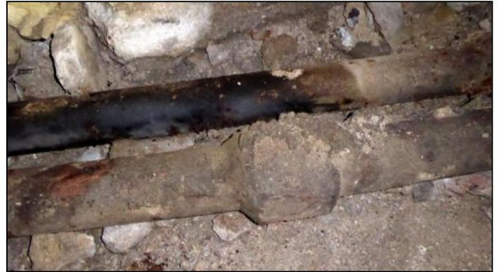
Fig. 31 : Cohabitant encore, des bourneaux du XIX<sup>e</sup> siècle et une conduite en fonte de 11 cm de diamètre et d'éléments longs de 1,5 m.
