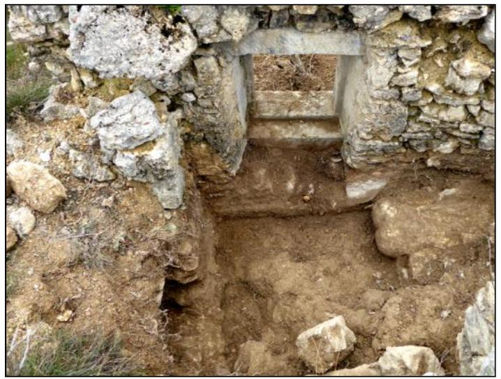
Fig. 34 et 35 : Le dégagement de la terre et des pierres a permis la mise à jour d'une serve dans le regard. A l'écoulement dans le bassin, à droite sur la photo, s'est formée une curieuse excroissance de tartre (tune)
