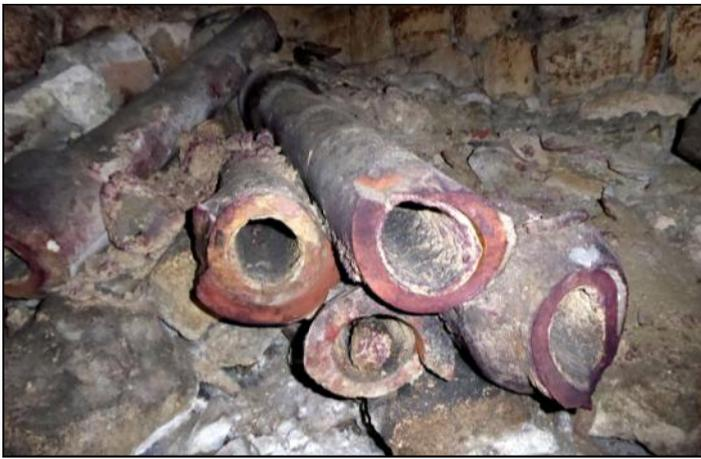
Fig. 29 : Bourneaux abandonnés dans les caves. Peu entartrés, longs de 1 m, ils datent du XIX<sup>e</sup> siècle.
