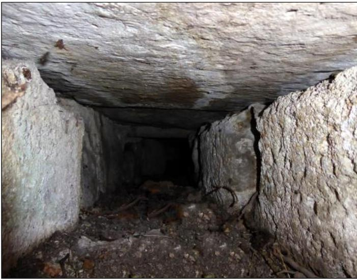
Fig. 19 : Seul vestige de conduite dallée découvert au chemin des Oliviers. Il mesure 0.25 m par 0.30.
