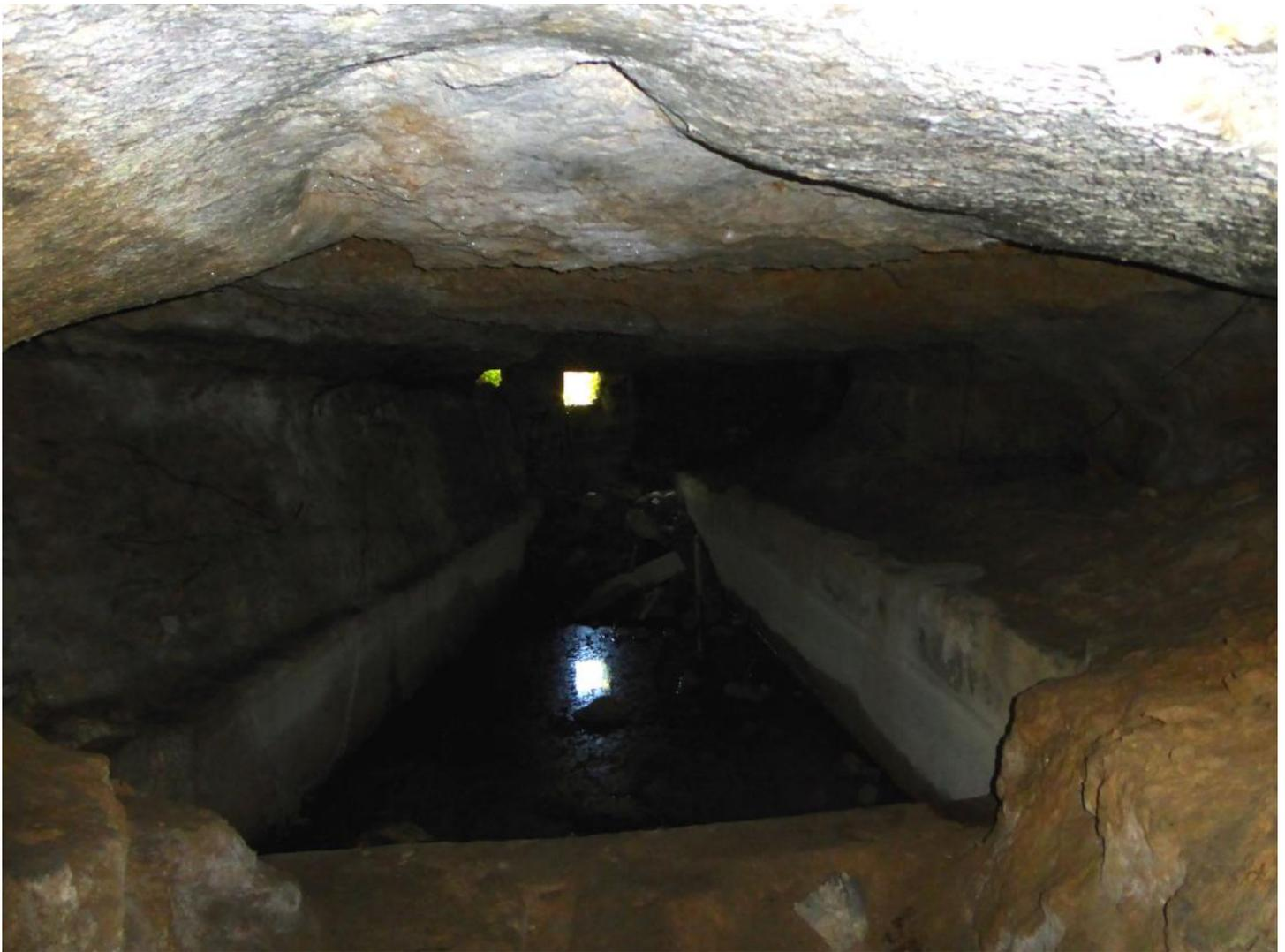
A 46 m de l'entrée, un puits remontant de 6 m débouche en surface où il est fermé par une dalle. Quelle fut l'utilité de ce puits lors du creusement ? Aération ? Evacuation plus rapide des déblais arrachés à la roche ? Il est étonnant de ne pas en trouver un autre, à une distance du même ordre, avant la fin de la galerie.
