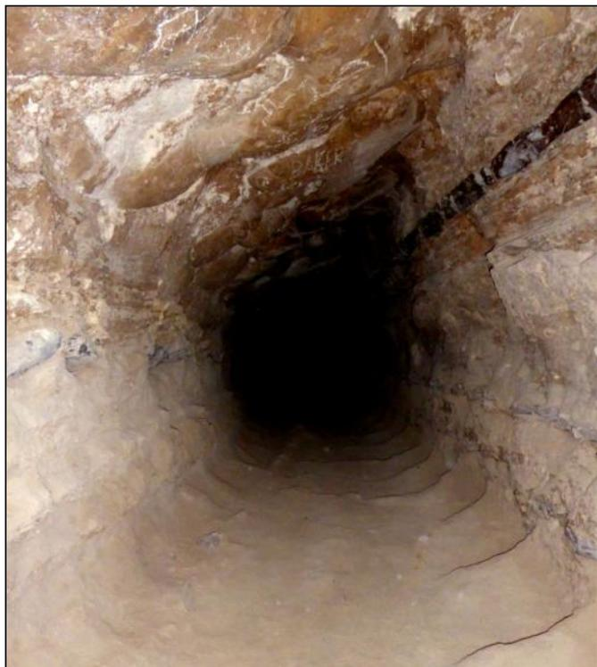
Après un virage à 50°, la galerie plonge en direction de la source en suivant les strates. Les marches creusées dans le roc sont usées par les multiples passages.
