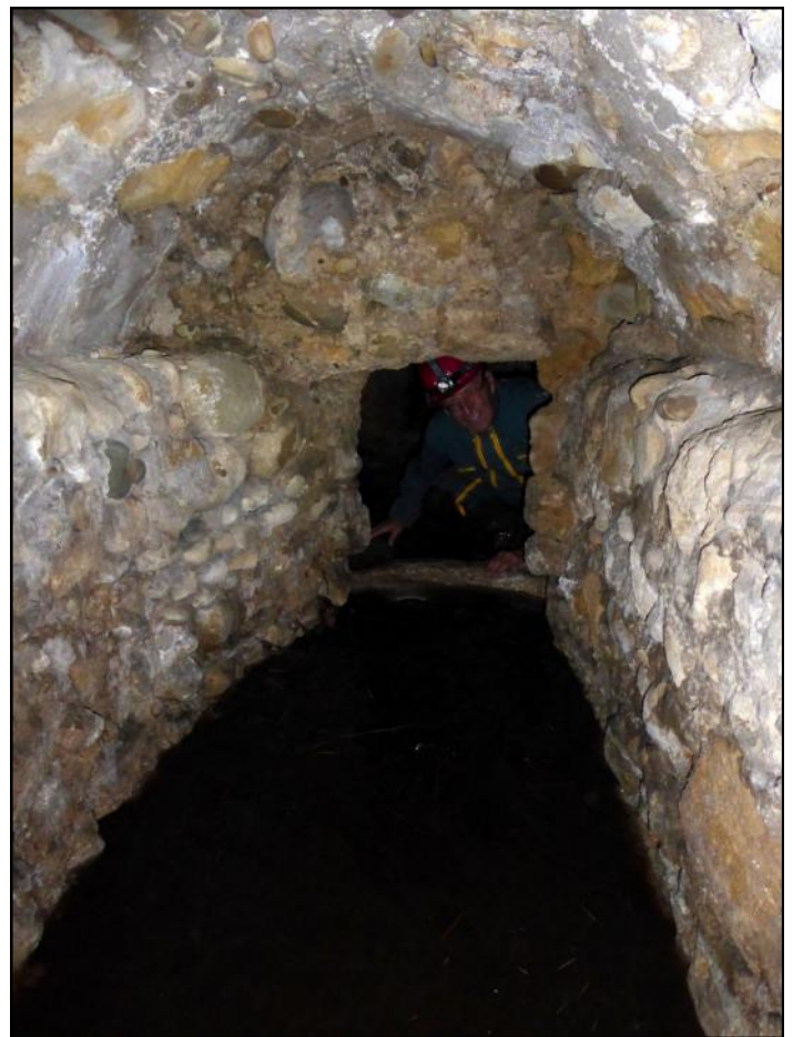
La petite entrée à la mine telle qu'elle apparaît quand on ressort.
