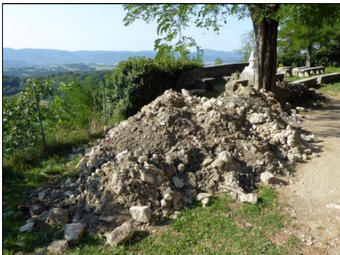
Sur 10 m de longueur, les déblais enlevés de la cavité par les bénévoles.
