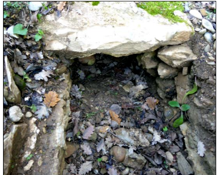
La conduite dallée qui mène l'eau de la mine vers Oraison.
