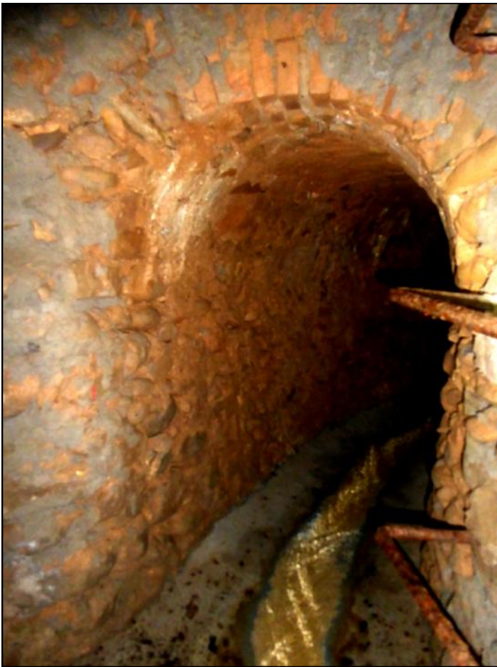
Le bas du second puits est au carrefour de deux captages d'eau. Ici, la voûte de la galerie est en briques.
