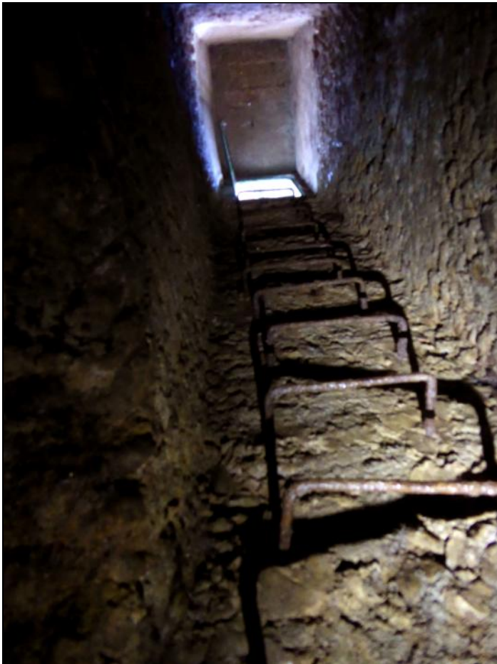
Le puits de 5,5 m qu'on descend pour accéder à la galerie.
