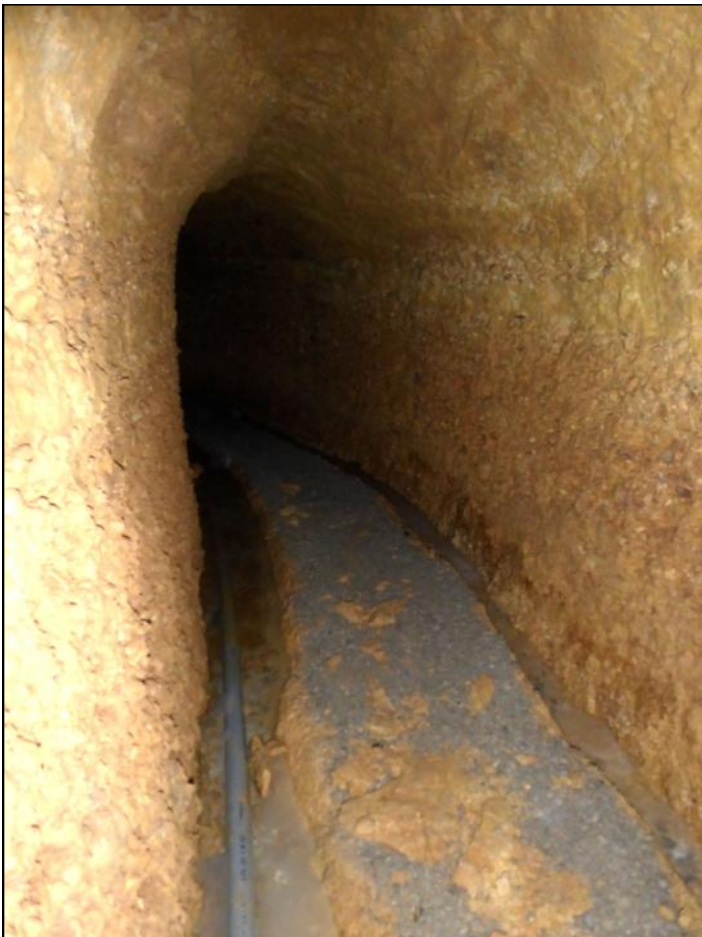
La seconde mine d'eau décrit elle aussi un grand arc de cercle difficile à expliquer. En bas à gauche, l'eau est en partie canalisée dans un tuyau en PVC.
