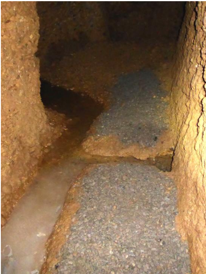
Les deux arrivées d'eau qui alimentent la galerie de la seconde mine d'eau.
