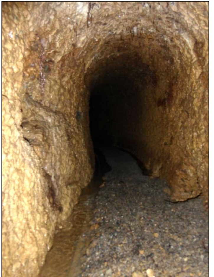
La galerie de la seconde mine d'eau n'est pas maçonnée, mais creusée dans un solide conglomérat de sable et de petits galets.
