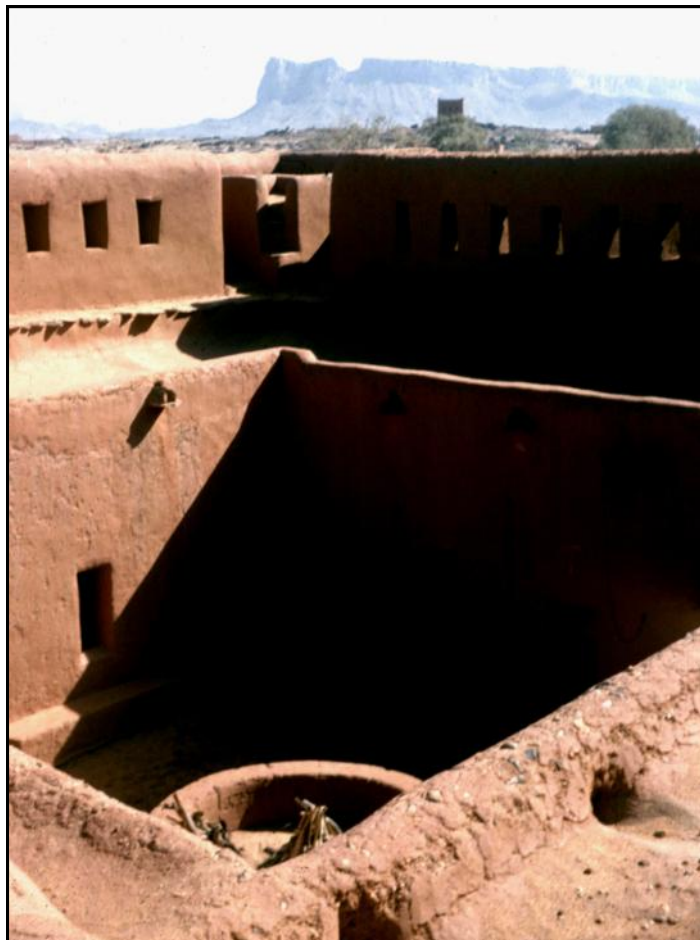
Quand de Foucauld était arrivé, il était encore militaire et sa maison avait une structure fortifiée avec un puits au milieu.
