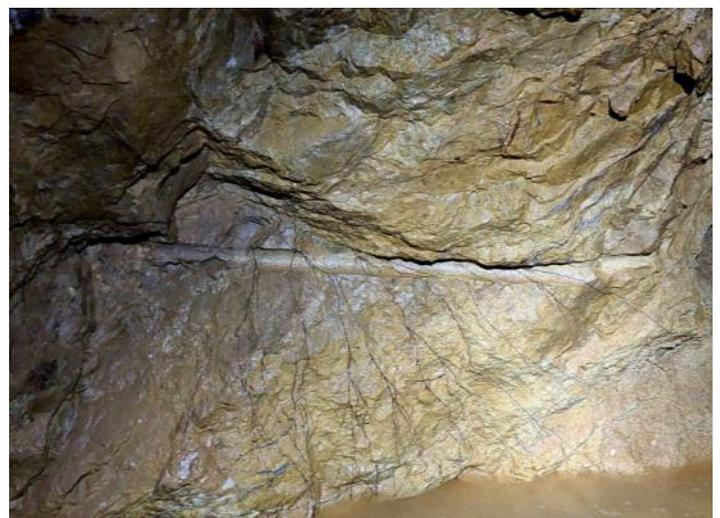
Les trous de barre à mine nécessaires à la taille du rocher.
