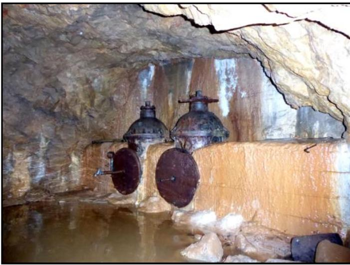
Le barrage créé par un éboulement de la voûte a formé une retenue d'eau qui va jusqu'au mur marquant la fin de la partie visitable de la galerie.
