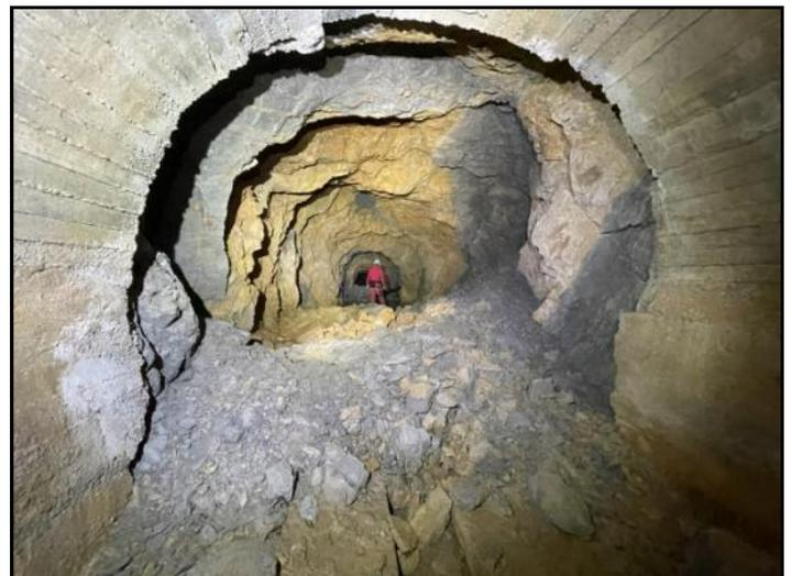
Après la fin de la galerie maçonnée, un éboulement a créé un barrage de 0.8 m de haut qui retient l'eau de ruissellement.
