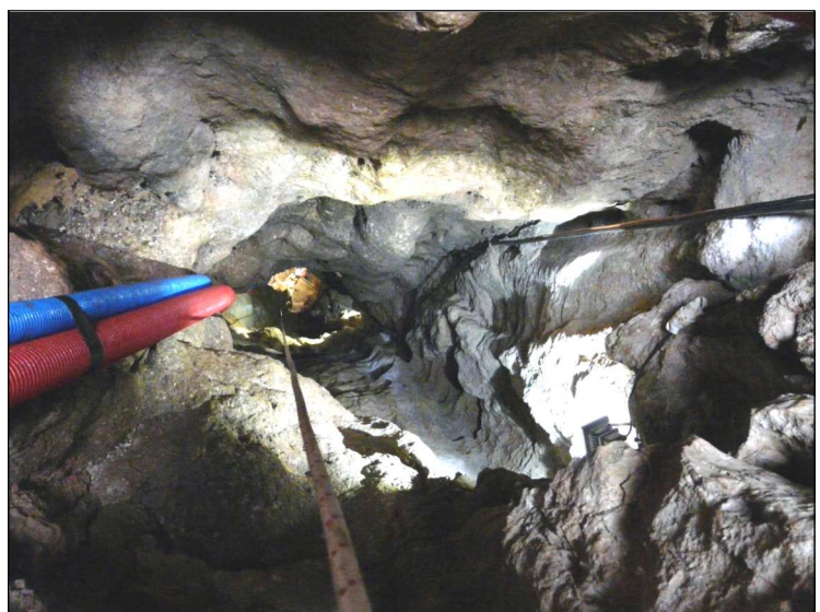
Le puits de 32 m au début, a été équipé de tuyaux pour aspirer le gaz carbonique abondant (Oxygène 17,5%)
