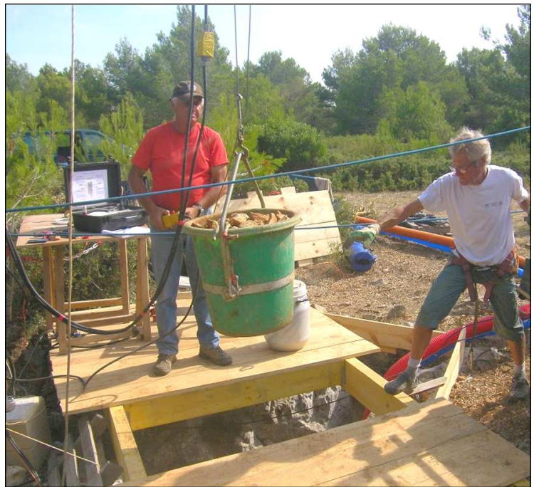
Les moyens ont été mis en œuvre : un portique avec un superbe treuil alimenté par un générateur. Le bidon de 70 litres pèse 150 kg quand il est plein.
