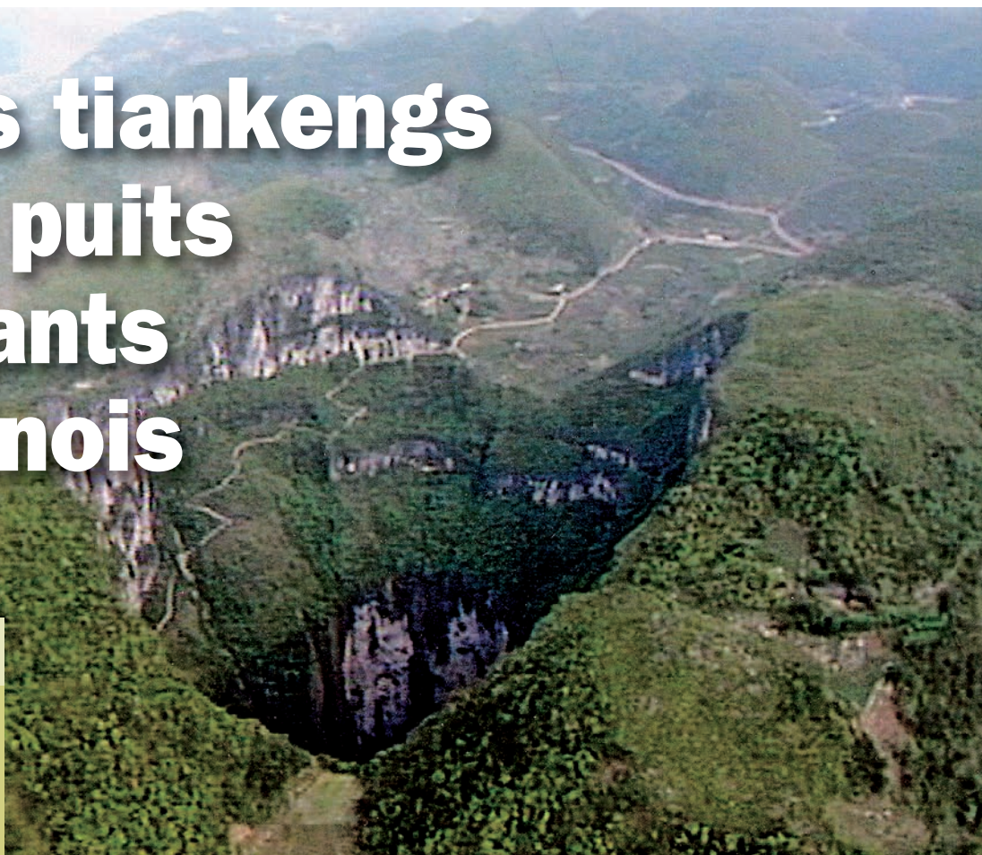
Vue aérienne de Xiaozhai, on aperçoit le chemin qui descend de 300 m dans le puits. Cliché Zhu Xuewen.
