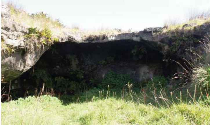
Entrée de la grotte des Otaries (île d'Amsterdam) : on remarque la minceur et la fragilité de la voûte.
