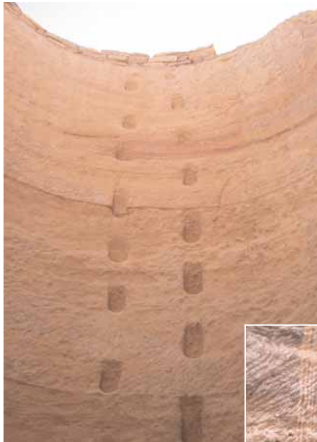
Dans les puits, on voit nettement les encoches creusées par les puisatiers pour descendre et remonter... La technique de spéléologie alpine est beaucoup plus sécuritaire ! Clichés Paul Courbon.
