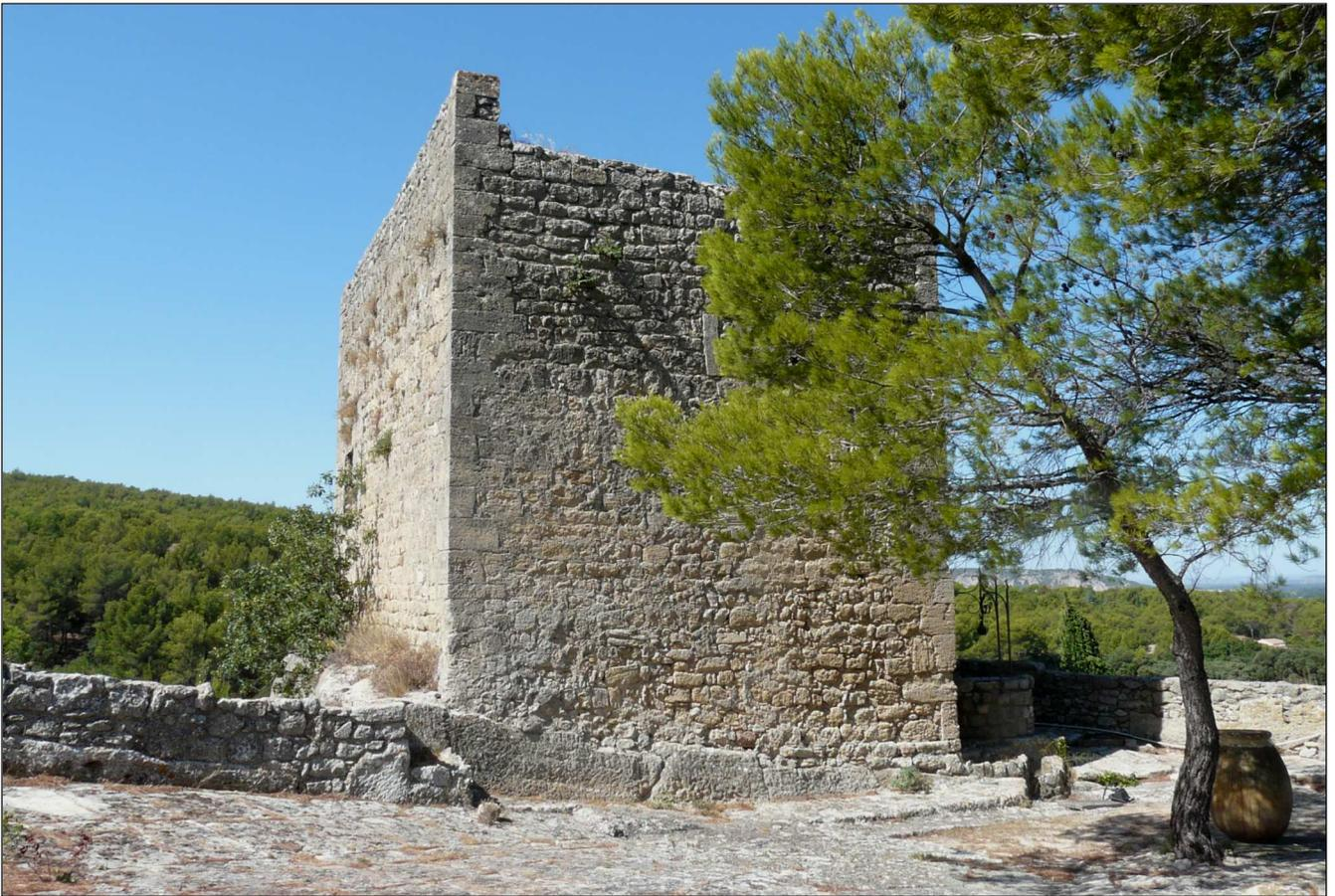
**Fig. 4 :** La terrasse dallée, dont la pente ramène l'eau vers la citerne située dans l'ombre au coin droit de la tour. Des pins ont réussi à trouver de quoi pousser! En haut à gauche de la tour, un mur témoin de plus grande hauteur.
