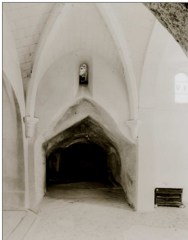
Fig. 9 : Le côté sud du transept. Au début, la voûte à deux pans caractéristique du Luberon. Ensuite, la hauteur de la voûte s'abaisse pour respecter l'épaisseur de la roche encaissante. On remarque les culs de lampe sur lesquels reposent les ogives (Inventaire général région PACA, G. Roucaute-M. Heller - ADAGP).
