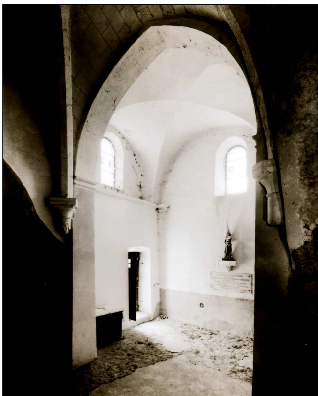
Fig. 8 : La nef vue du chœur. A gauche, la porte d'entrée taillée dans le roc, seule la fenêtre s'ouvre dans un mur bâti. Par contre, le mur du fond est entièrement bâti et a raccourci la nef initiale (Inventaire général région PACA, G. Roucaute-M. Heller - ADAGP).
