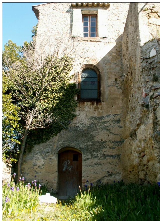
Fig. 3 : Au fond du jardin, une porte anonyme donne accès à la chapelle. Au dessus, la fenêtre éclairant la nef. On distingue la roche où se creuse la chapelle. Seule la partie haute de la nef est bâtie.
