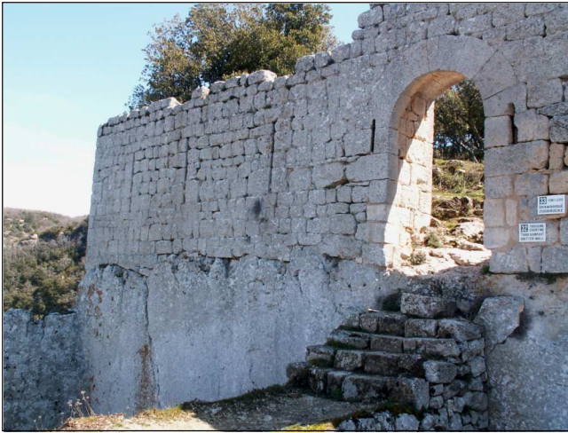
Fig. 15 (en haut) : Le troisième rempart protégé par le fossé entièrement creusé dans le roc. Un passage bâti a remplacé l'ancien pont-levis.
