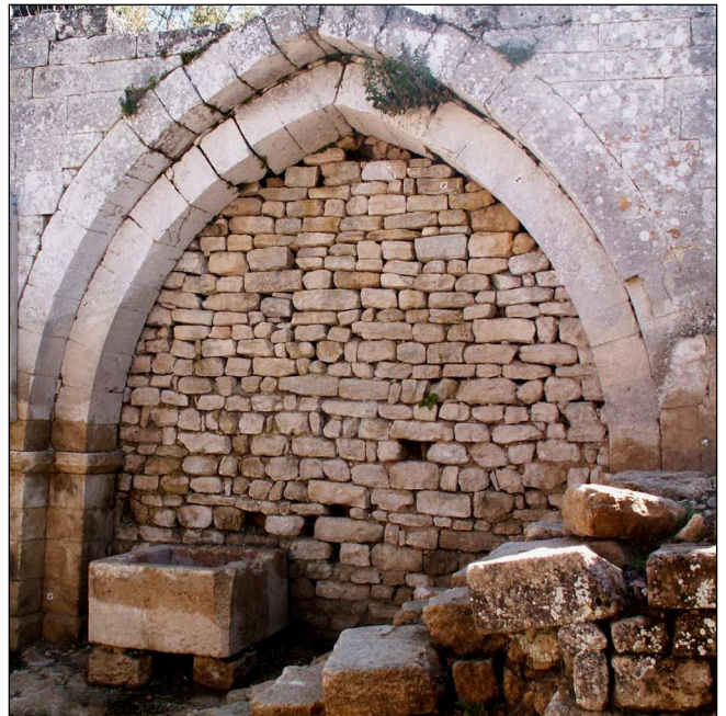
Fig. 5 : L'un des beaux appareillages qui subsistent de l'église.
