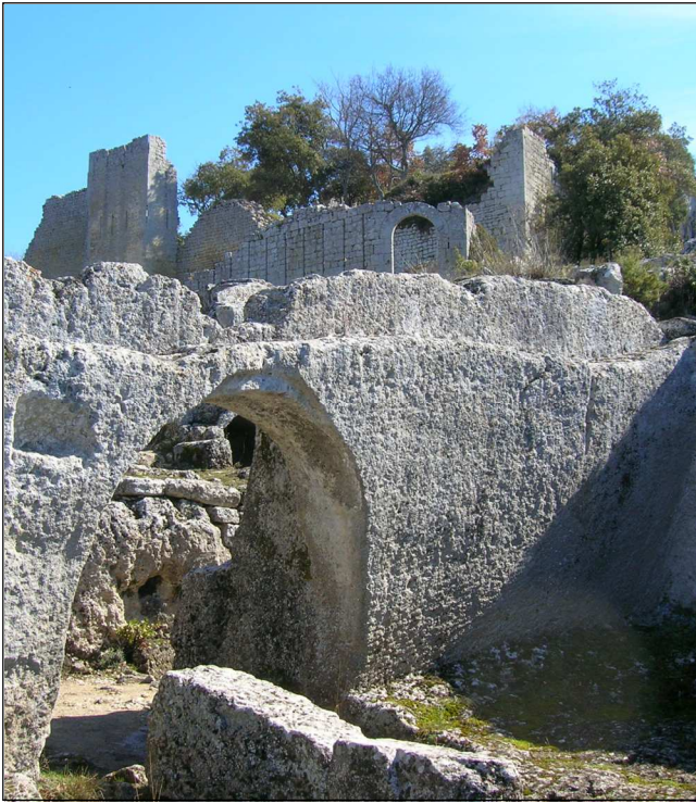
Fig. 10 : derrière la dernière maison du village, le premier rempart suivi de près par le second. De ce point de vue, les fossés en partie comblés, sont invisibles.
