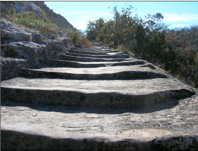
Fig. 3 : Par endroits, le chemin d'accès a dû être taillé dans la roche escarpée.
