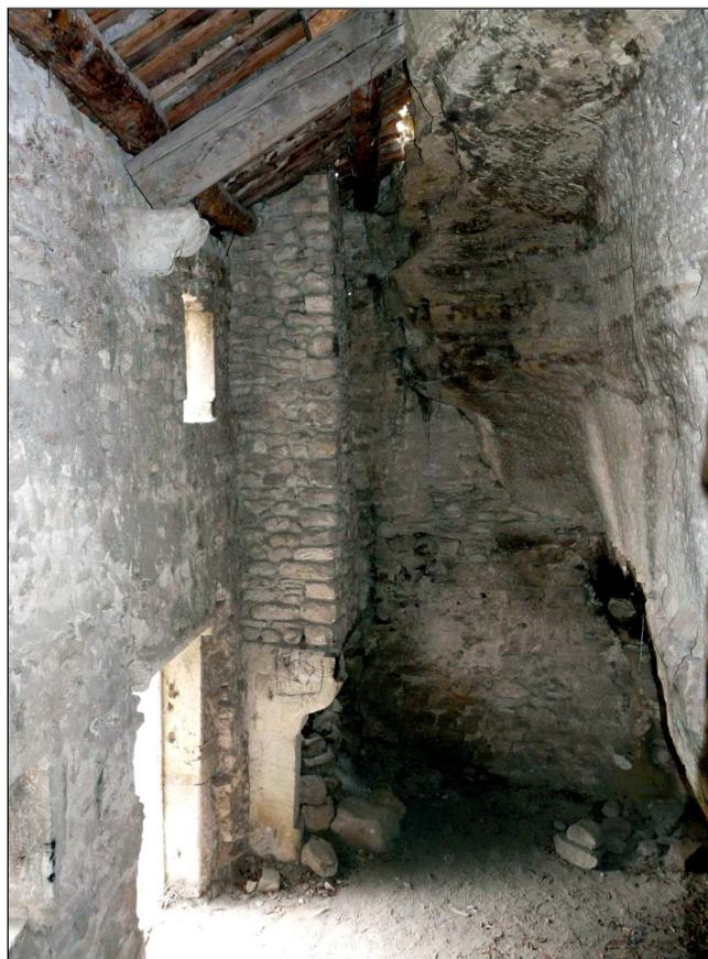
**Fig. 5 :** une maison restaurée vue de l'intérieur. Le plancher entre les deux niveaux a disparu. Le toit est à moitié couvert de tuiles et à moitié rocheux. Le rez-de-chaussée s'enfonçait plus profondément dans la roche.
