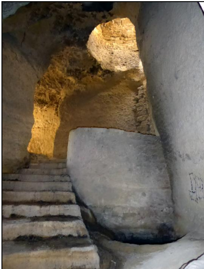
Montant au puits, les escaliers qui ont été refaits par la mairie, avec une consolidation des murs et de la voûte. En bas, la belle perspective du puits remontant jusqu'à la surface.
