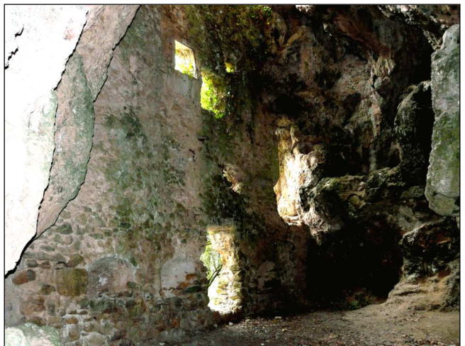
Fig. 3 : Intérieur de la forteresse. La porte d'accès domine le sol extérieur de 2,5m. A gauche de la porte, deux meurtrières, au dessus, des trous de boulin.
