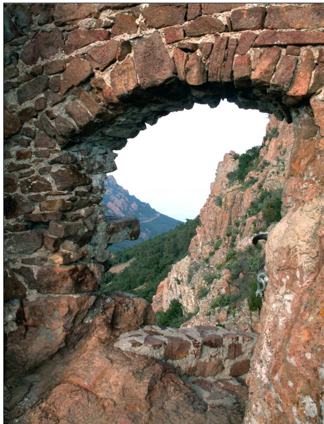
Fig. 12 : La porte vue de plus près, sa construction est frustre, avec des pierres locales. Au fond, non visibles à cause de la brume, les deux îles de Lérins.
