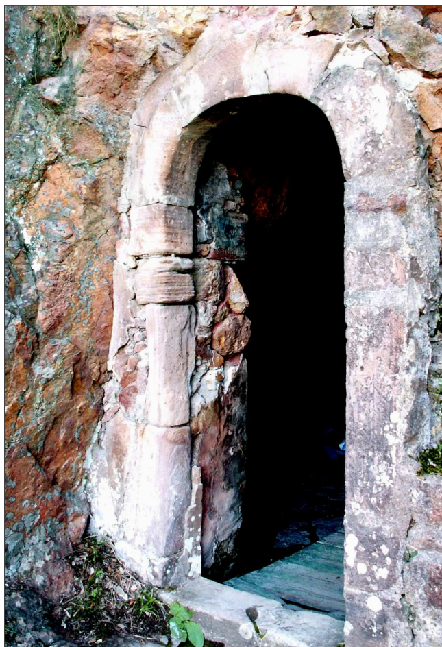
Fig. 8 : le montant gauche de la porte, réparé maladroitement, ne choque pas.
