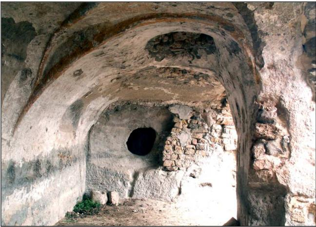
**Fig. 9 :** Dans la moitié est, deux trous au plafond, étaient-ils destinés à actionner les cloches ou plus tard, à écouler du blé? Au fond, un trou dans la paroi communicant avec un local voisin.
