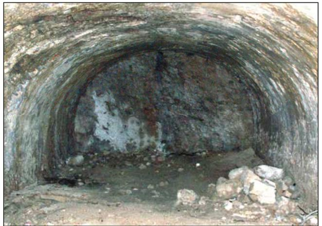
Fig. 16 : Une citerne encore visible sous les vastes bâtiments en ruine. Tout le crépi d'étanchéité est encore intact.
