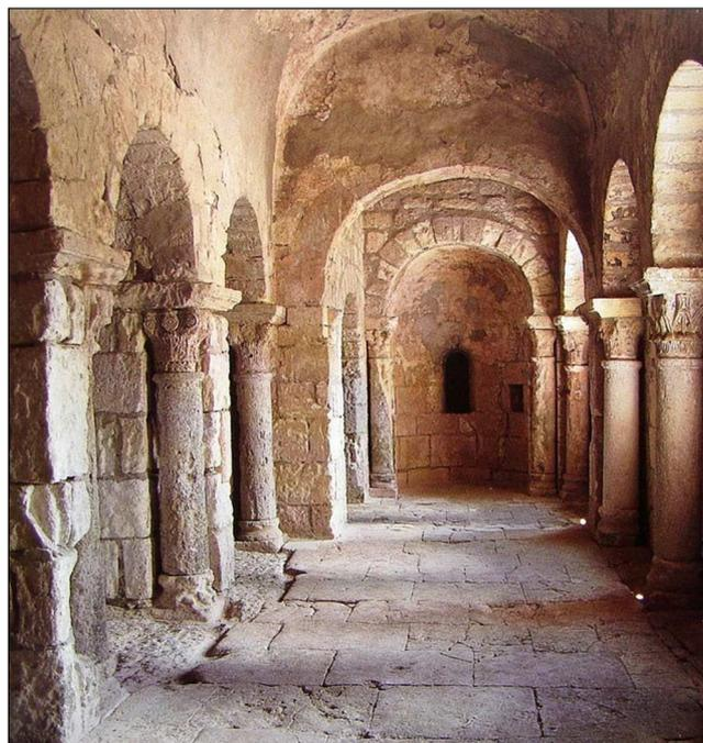
**Fig. 9 : La seconde nef, datée de 1040 env. Bien qu'en partie recouverte par le rocher, sa voûte est entièrement maçonnée.**
