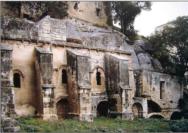
**Fig. 11:** Vue extérieure, les quatre contreforts sont construits au XV<sup>e</sup> siècle pour soutenir la façade.
