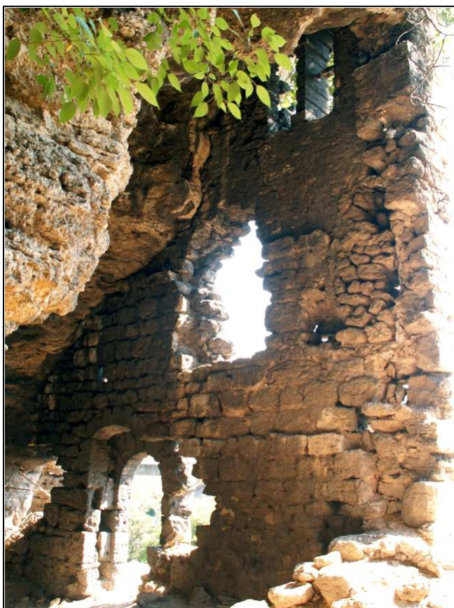
Fig. 3 : Cette vue de l'intérieur confirme l'état de délabrement vu en figure 1. Remarquer les deux corniches (une à hauteur de la voûte de la porte). Au dessus de la plus haute le crépi succède aux pierres apparentes.
