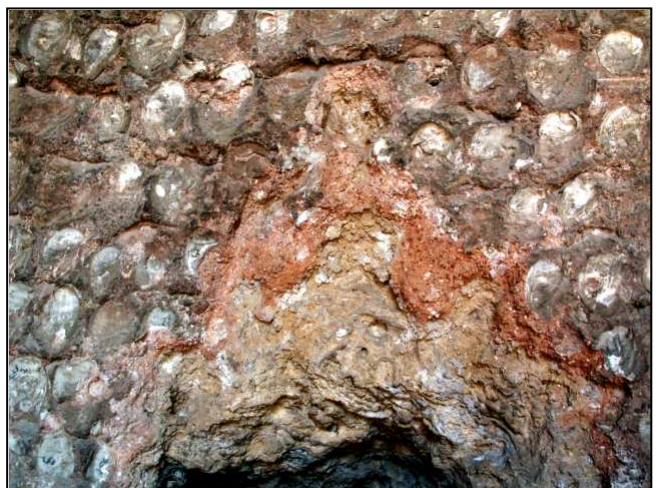
Fig. 11: Vu en détail, le scellement des coquillages commence à se dégrader sérieusement. L'analyse du mortier rouge de scellement permettrait sans doute une datation : XIII e ou XVII e siècle?
