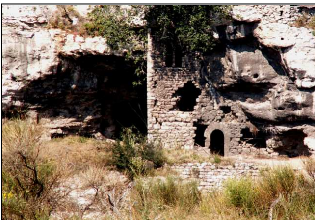
Fig. 1 : L'ermitage en bien piteux état, dans sa grotte sous une zone urbanisée. A gauche, l'abri des ermites.
