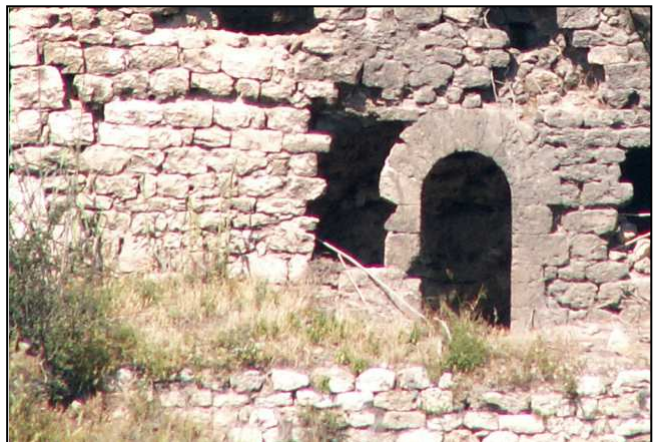
Fig. 7 : Appareillage en travertin de la porte.
