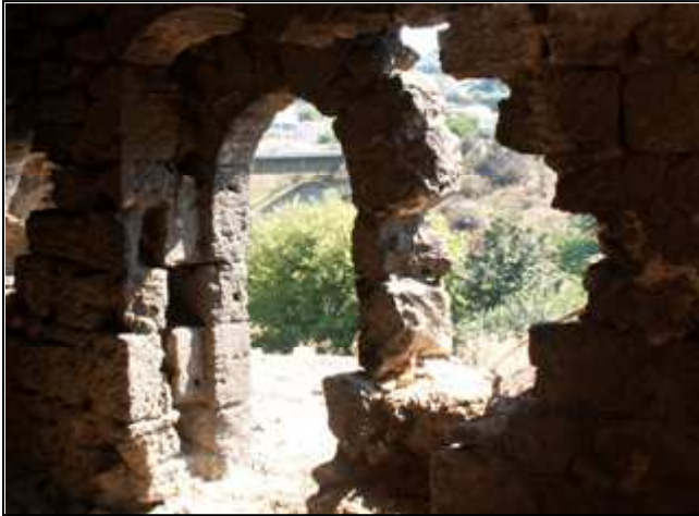
Fig. 11 : La porte d'entrée vue de l'intérieur avec son double appareillage en travertin. Le mur est dans un profond état de délabrement. Avant son écroulement, une étude de ses traits architecturaux sera-t-elle faite en vue d'une meilleure datation?
