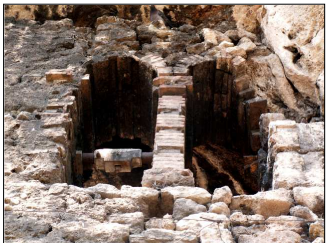
Fig. 8 : Les fenêtres géminées où se logeaient les cloches. Leur appareillage en briques diffère de celui de la porte et témoignerait d'une période de construction postérieure.
