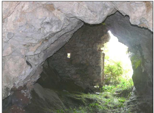
Fig. 5: Le mur de défense vu de l'intérieur. On distingue bien la feullure de la porte, mais au dessus de celle-ci, on ne voit pas la meurtrière en travers, flanking la vire d'accès.
