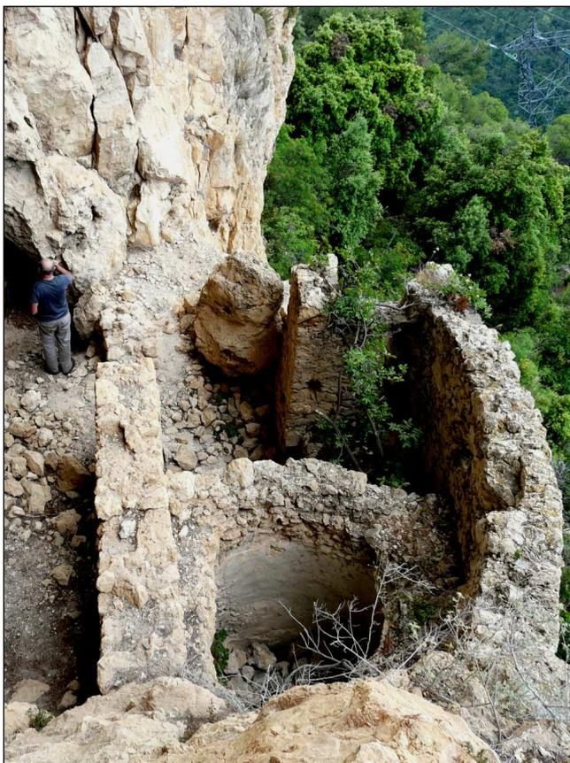
**Fig. 7:** Vue à partir du rocher au centre de la forteresse. On distingue bien le crépi intérieur de la citerne, le bastion d'entrée et les deux murailles. Le tout était vraisemblablement recouvert par une terrasse alimentant la citerne.
