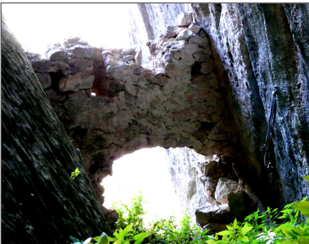
En bas, le mur vu de l'intérieur, avec à gauche la meurtrière plongeante.
