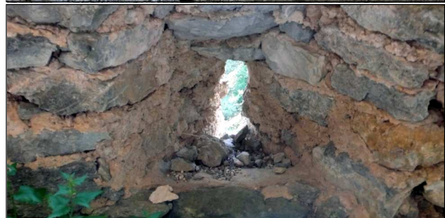
Les meurtrières pour armes à feu qui percent la courtine et le bastion.
