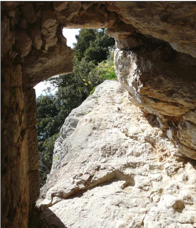
**Fig. 6 :** Ce qui reste de l'appareillage de la porte. Au dessus de l'arceau qui a disparu, il y avait un regard horizontal. Au sol, le creusement et la crapaudine où s'articulait la porte. Le montant droit a disparu.
