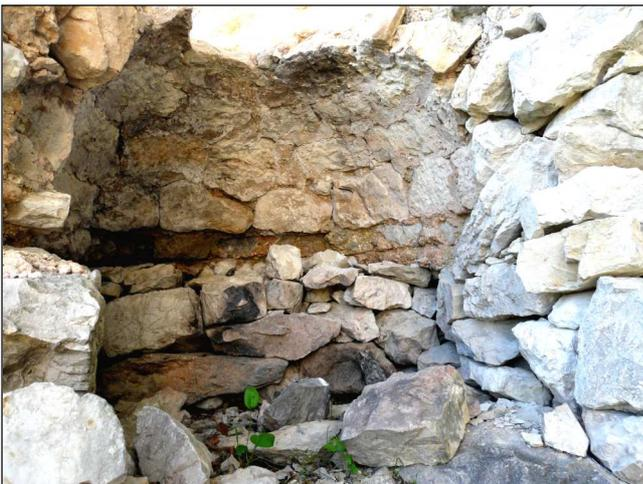
**Fig. 10 :** Ce qui reste du four dont la partie antérieure est détruite. La demi-sphère est soigneusement maçonnée. On distingue à sa base la rainure où s'encastrait la sole en cinérite aujourd'hui disparue.
