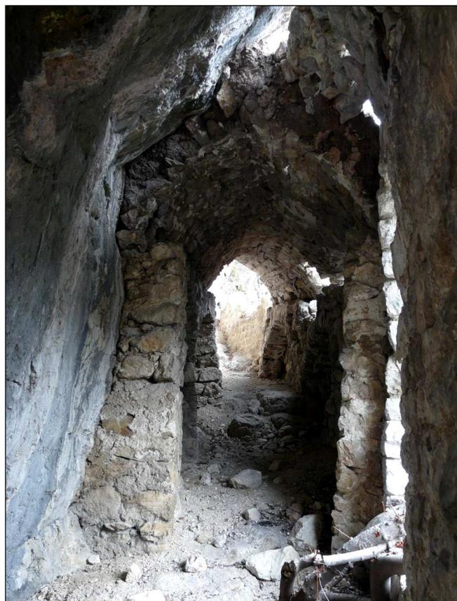
**Fig. 6 (haut):** La partie longue de 7m, avec une voûte en ogive. Devant, le toit rocheux formé par la paroi a évité la construction d'une voûte, le mur est incurvé.
