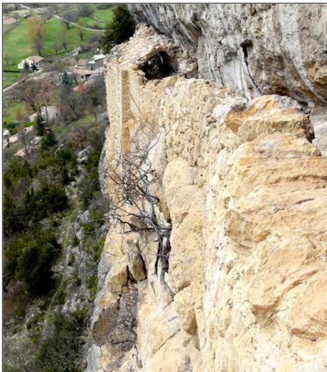
**Fig. 9 :** La vue extérieure du mur de la forteresse montre son caractère inexpugnable. Pas besoin de meurtrière de ce côté! La maçonnerie frustre de la courtine contraste avec le côté plus soigné de l'arête précédant la galerie.
