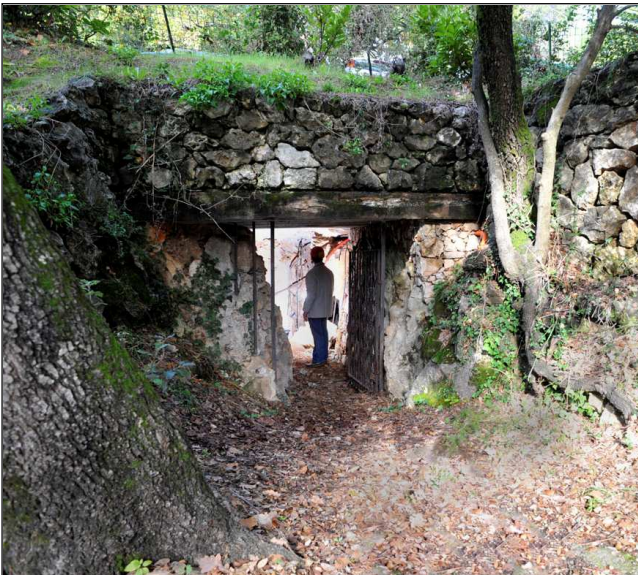
Fig. 2 : Entrée de la galerie d'accès (Ph. B. Hof).
