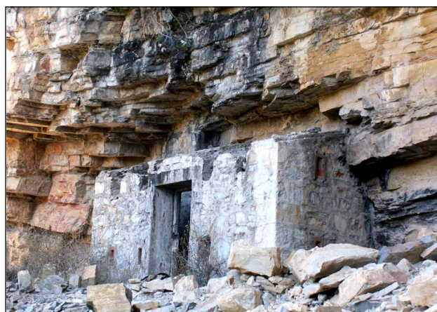
Casemate, les meurtrières du haut ont disparu, le linteau de la porte est en béton et la meurtrière coudée n'offre qu'un petit champ de vision.
