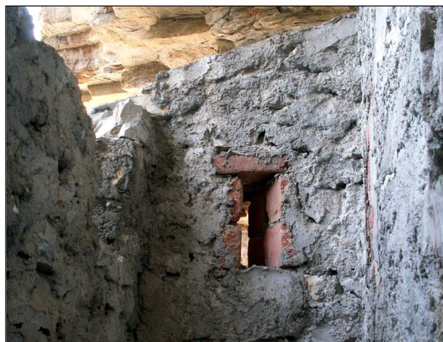
Casemate, les meurtrières du haut ont disparu, le linteau de la porte est en béton et la meurtrière coudée n'offre qu'un petit champ de vision.
