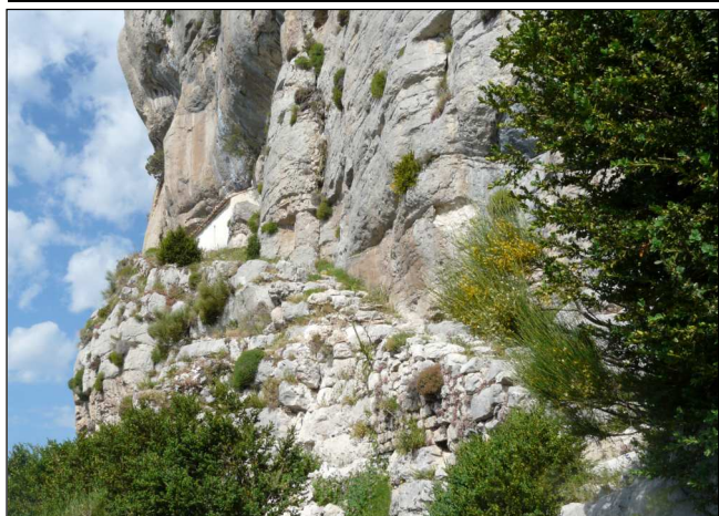
Fig. 1 : Les escaliers menant à la chapelle. Juste en dessous et non visible sur la photo, les ruines du vieux Robion.
