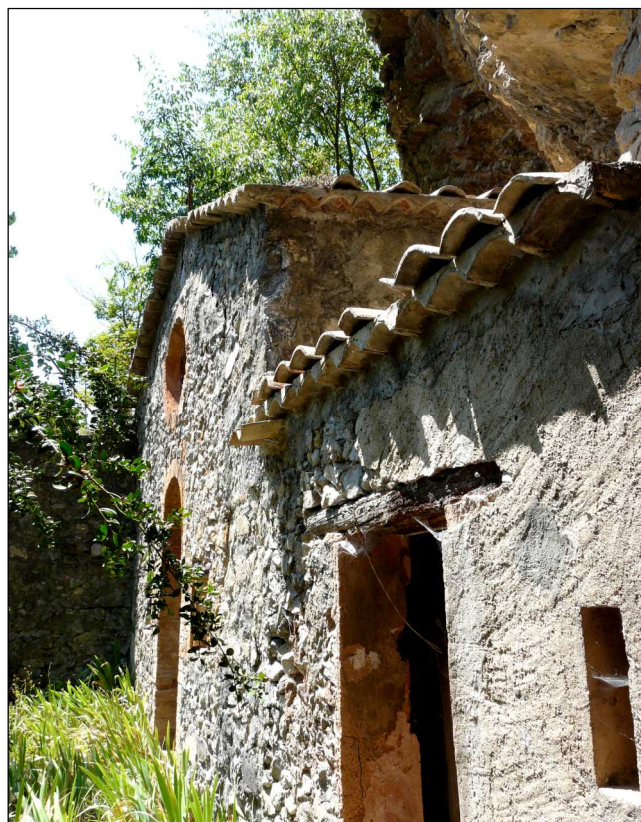
Fig. 3 : le petit appentis à droite de la chapelle, séparé de celle-ci par un épais mur plus ancien.
