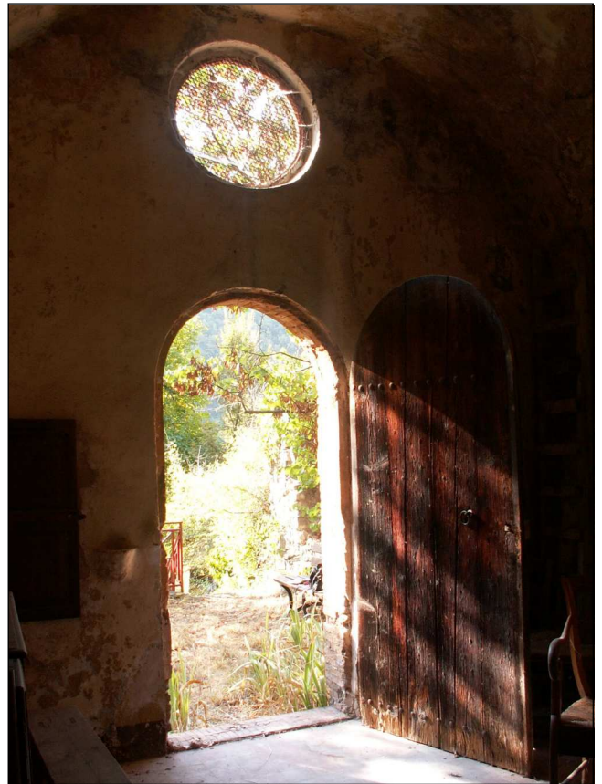
Fig 5 : L'entrée vue de l'intérieur, juste à gauche de la porte, un bénitier rustique, peu visible sur la photo.
