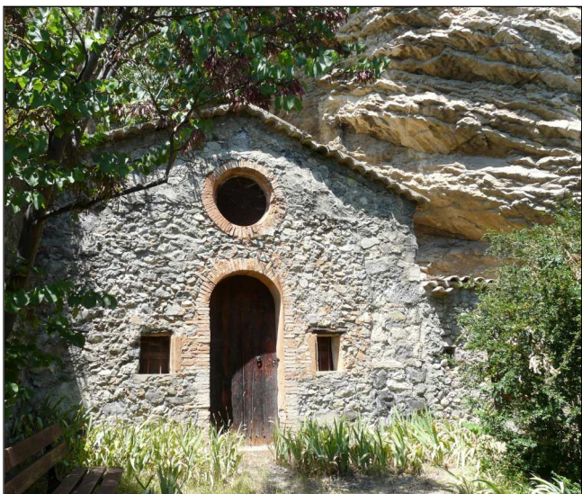
Fig. 2 : La chapelle et sa maçonnerie de type moderne. Seule l'amorce de mur à droite est plus ancienne.
