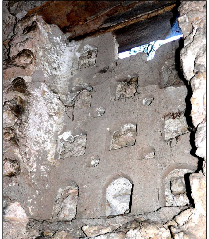
La plaque en ciment moulé scellée avec orifices pour les pigeons. Les ouvertures en ont été obstruées par la suite. Comme la facture des niches, elle indique un aménagement relativement récent.
