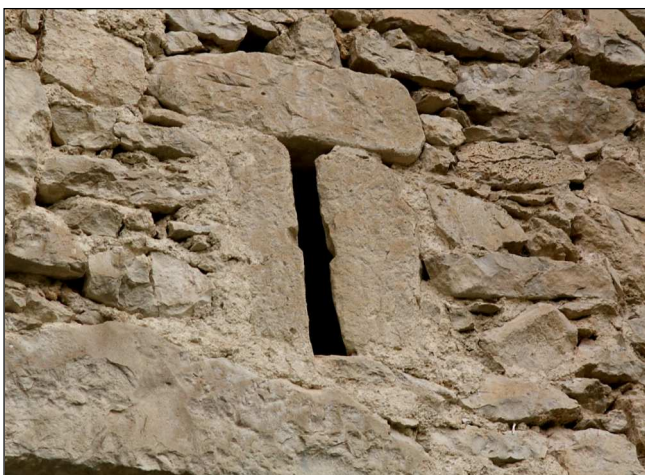
Fig. 3 : Juste au dessus de la porte, dont on distingue le beau linteau de pierre, s'ouvre une meurtrière au bel appareillage.
