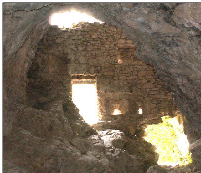
Fig. 4 : Le mur vu de l'intérieur. Le haut s'est écroulé, mais devait laisser un passage pour la fumée. En bas à droite, le mur a été cassé, sans doute pour laisser entrer les moutons.
