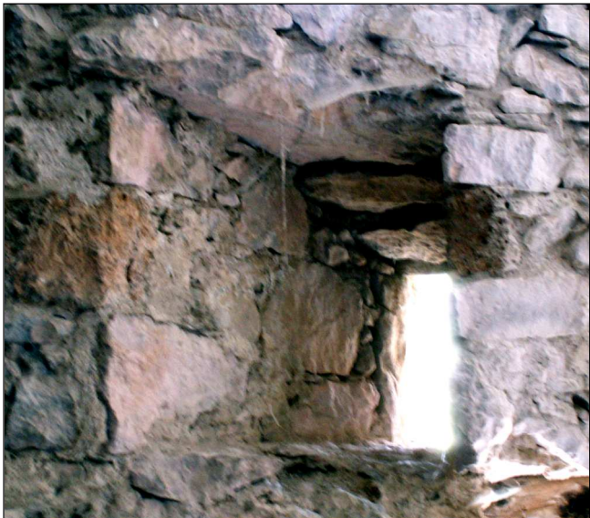
Fig. 7 : La meurtrière en meilleur état s'ouvre au dessus de la porte.
