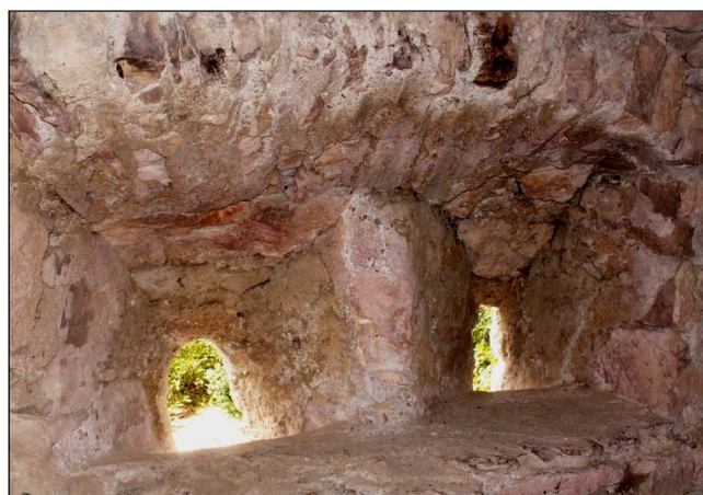
Fig. 5 : La meurtrière double, sa forme montre qu'elle ne pouvait être utilisée qu'avec une arme à feu, ce qui en limite l'ancienneté.
