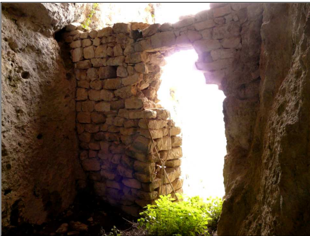
Fig. 5 : Vestige du mur d'entrée. De jolies pierres, mais pas de meurtrière.
