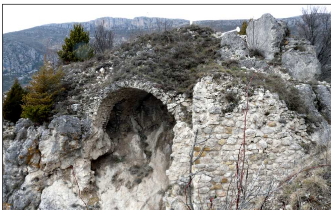
L'un des beaux vestiges de la structure nord. La comparaison de la photo de 1960 (en haut) et de la photo actuelle montre l'effondrement de la voûte avancée (2003).
