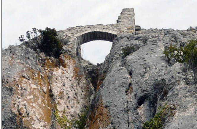
Côté ouest, cette structure correspondait-elle à l'emplacement d'un système de levage qui permettait de hisser jusqu'à la forteresse les biens à protéger?
