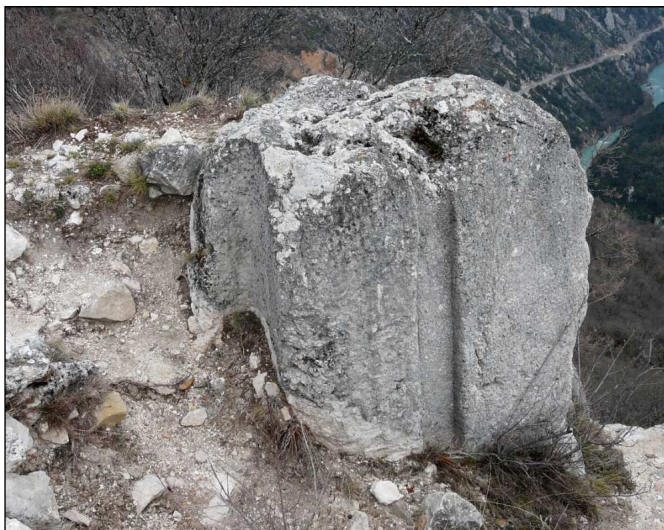
Vestige de la porte d'accès à la plateforme nord qui devait glisser verticalement, comme une herse. Sur la photo suivante, on voit les marches d'accès taillées dans le roc et précédant la porte.
