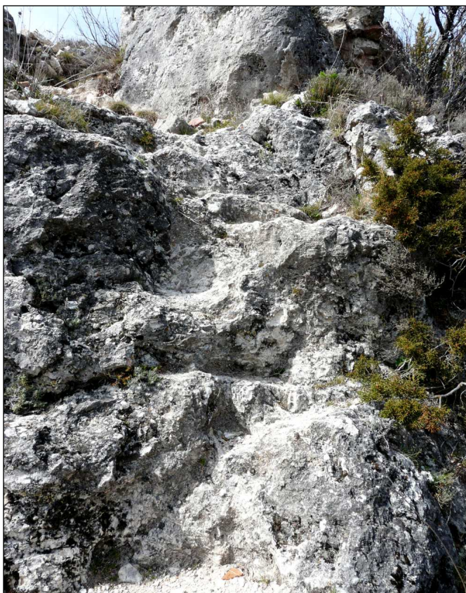
Vestige de la porte d'accès à la plateforme nord qui devait glisser verticalement, comme une herse. Sur la photo suivante, on voit les marches d'accès taillées dans le roc et précédant la porte.
