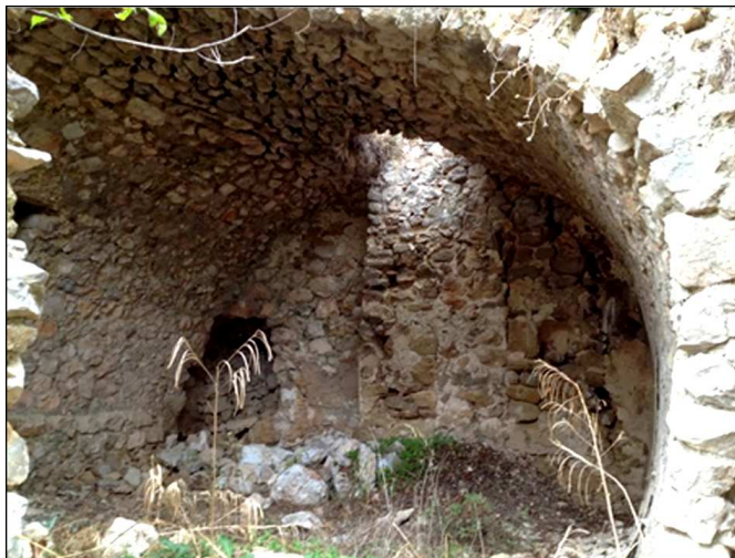
Photo de N. Despinoy prise au Bousquet, avec une voûte au rez-de-chaussée d'un bâtiment. La technique de construction rappelle celle de N.D. du Trou, mais il y a ici une cheminée, ce qui n'est pas le cas au Trou.
