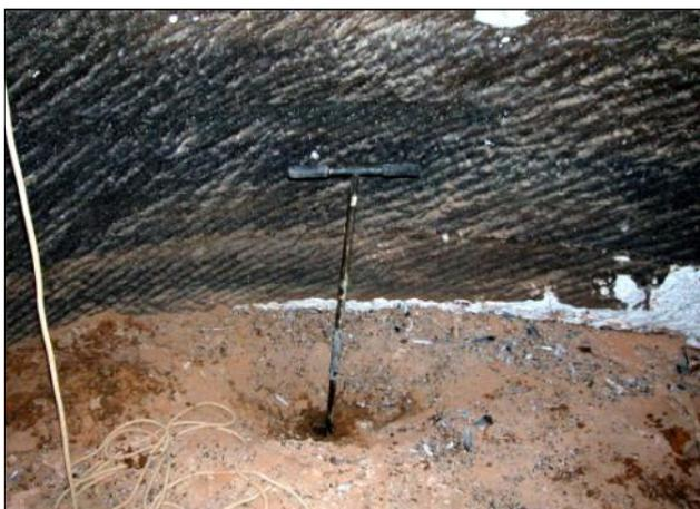
Il faut ajouter que la couleur de la paroi change 0,6 m au dessus du fond sableux actuel, ce qui ajouté au 1,2 m de notre carottage, indique vraisemblablement une zone noyée sur une hauteur de 1,8 m quand le puits était exploité. Hauteur nécessaire pour constituer une bonne réserve d'eau (env. 70 m<sup>3</sup>) et permettre un bon pompage. Le total de 2,5+1,8 nous donnait une différence de 4,3 m par rapport à la nappe phréatique en 2005, cohérente avec la baisse du puits Mutlaq.
