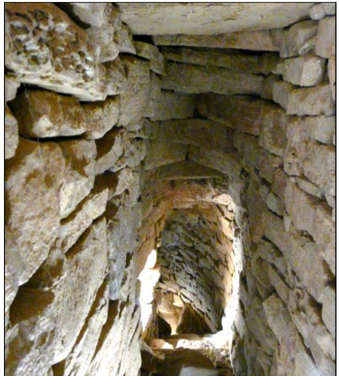
L'un des escaliers circulaires entourant certains puits.
