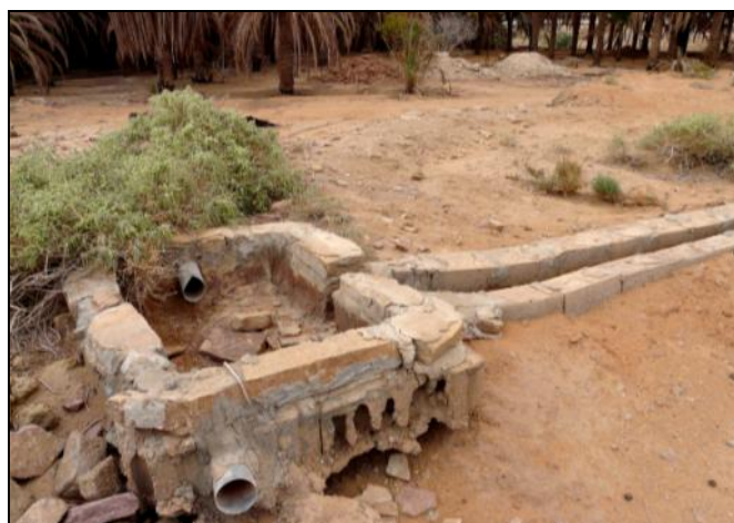
Les vieux réseaux abandonnés, partant des puits
