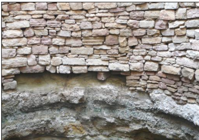
La maçonnerie en blocs de siltite assemblés sans mortier repose sur le roc de Sha'iba member, plus solide et d'un diamètre de creusement plus faible.
