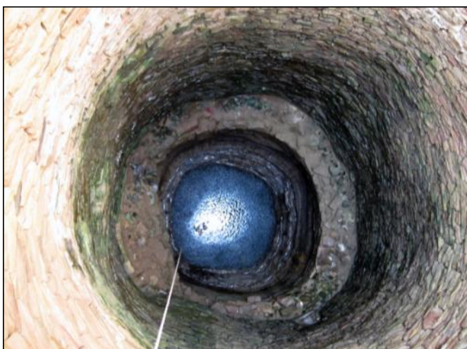
La maçonnerie en blocs de siltite assemblés sans mortier repose sur le roc de Sha'iba member, plus solide et d'un diamètre de creusement plus faible.
