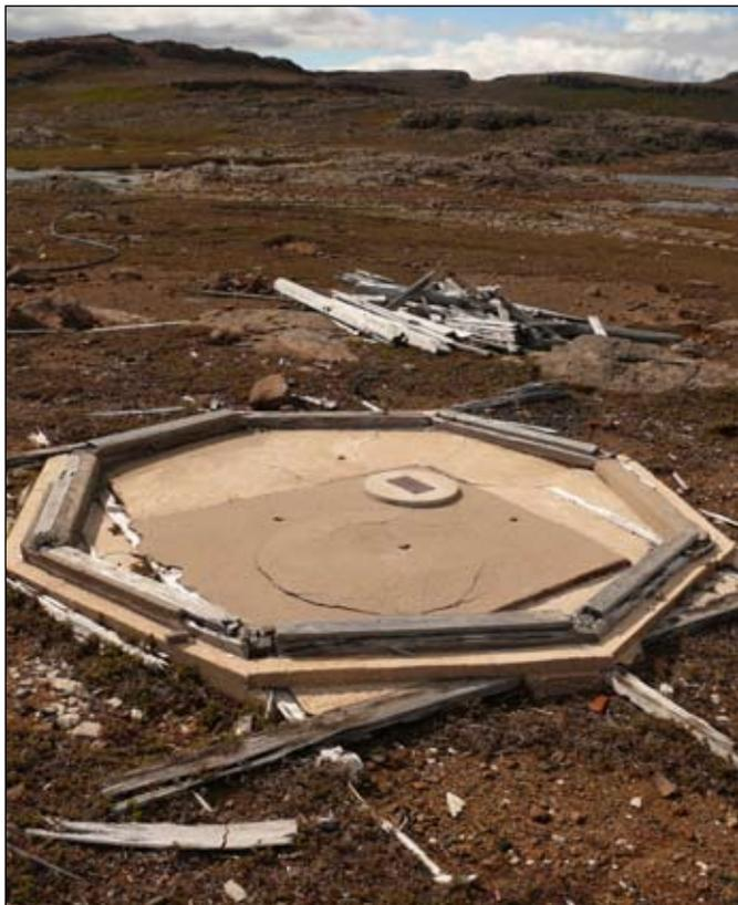
fig 48 a : Etat actuel de l'Absoluthaus. La fissure circulaire dans le ciment indique la dalle en grès, au fond, les montants de la structure verticale. (Ph. A. Barbot)
