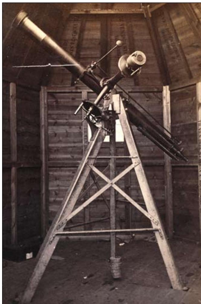
fig 28 : Une lunette astronomique à monture équatoriale : la lunette tourne autour d'un axe parallèle aux pôles, ce qui permet de suivre plus facilement le mouvement des astres (Doc. britannique).
