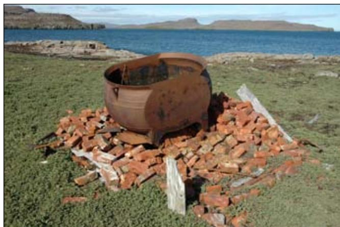
fig 76 : Photo de l'un des deux chaudrons de la « petite usine ». Le socle en briques s'est effondré et l'on distingue encore deux piquets bois qui devait soutenir un abri contre le vent. Un peu partout, des traces noires correspondant au charbon. (ph. J.F. Le Mouél)
