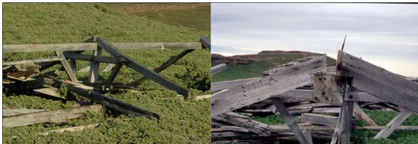
fig 34 a : Les fermes avant dégagement. A gauche, on distingue la ferme V avec les deux arbalétriers sur la panne faîtière, le poinçon, les jambes et l'entrait simple. A droite, en avant plan les deux arbalétriers de la ferme VII qui masquent en partie la ferme V. (ph. J.F. Le Mouél).
