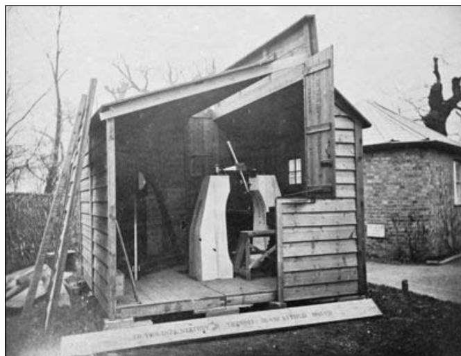
fig 16 : cabane prévue pour le passage de la lune au méridien. Les pierres de transit sont alignées est-ouest et au plafond, un volet s'ouvre dans la direction nord-sud (Doc. britannique).
