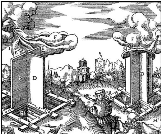
Parmi ces méthodes, il y avait des panneaux de bois disposés judicieusement à l'entrée du puits et dans le puits, pour utiliser la force du vent en vue de l'aérage. Il y avait même des tonneaux étonnamment aménagés pour capter le vent. Mais, évidemment l'efficacité d'un tel système était liée à la présence du vent et à ses caprices (voir figure).
