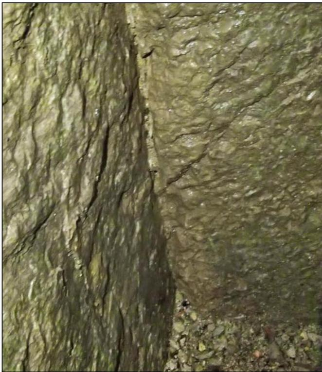
**Au fond du puits de Besançon, la mise à profit de fractures naturelles a donné une section carrée.**
