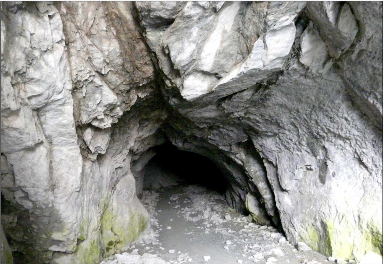
Côté italien, la zone de fracturation empruntée par le tunnel apparaît très nettement. Le profil de la galerie épouse la direction de la fracturation : ses parois ne sont pas verticales et la hauteur du plafond n'est pas régulière.
