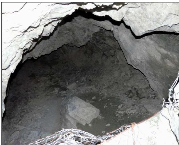
**Du coté français, on voit le treillage de fil de fer fixant les blocs éboulés. On distingue aussitôt les irrégularités de la taille de la galerie.**
