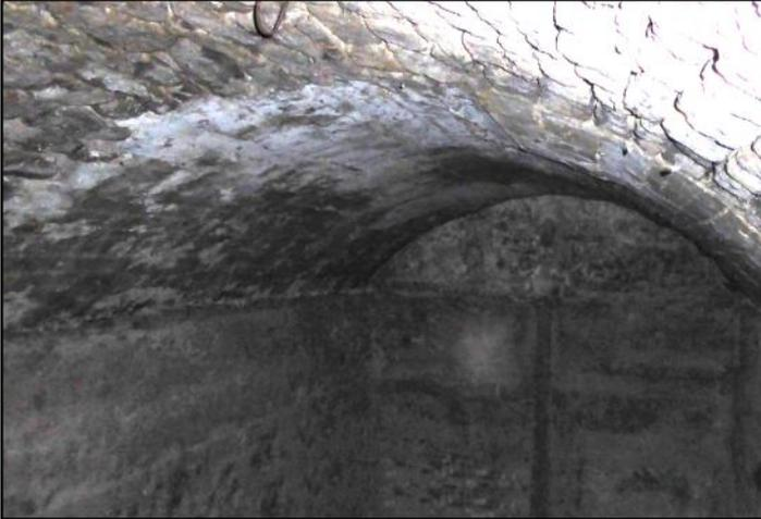
La vieille citerne de 70 m<sup>3</sup> du couvent de Saint-Promasse n'est pas carrelée, mais a un enduit d'étanchéité de mortier.
