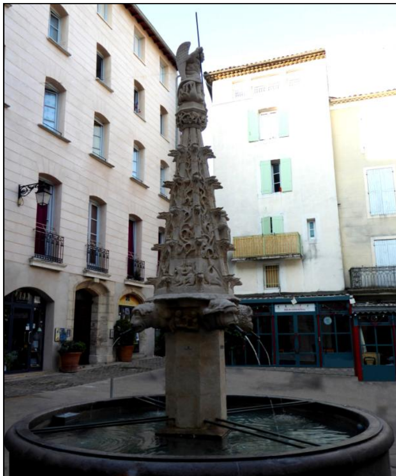
Enfin, ci-dessous, la fontaine telle qu'elle apparaît aujourd'hui. En 1976, les sculptures au niveau des dégueuloirs ont été rafraîchies, alors que la partie au dessus a été entièrement refaite à l'identique. Il n'y a plus de calade, remplacée par des dalles de pierre en 1986.
